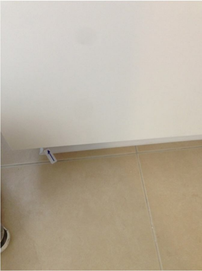
5. ขาดตีนตู้ไม้สนิท (ตู้เฟอร์นิเจอร์หน้าห้องน้ำ + ชิงค์ล้างจาน)
