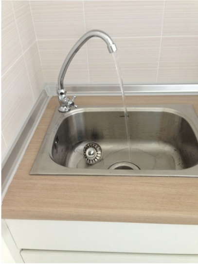
7. น้ำไหลไม่แรงตรงซิงค์ล้างจานให้เช็คอุปกรณ์และท่อ
