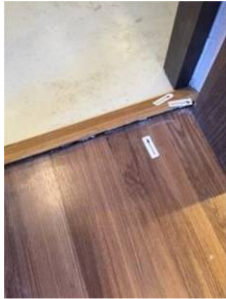
12.พื้นไม้ทางเข้าห้องครัววม
