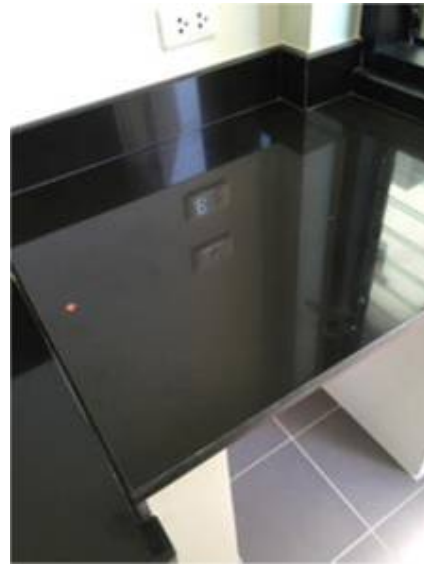
2.เก็บงานซิงค์ตรงเคาน์เตอร์
