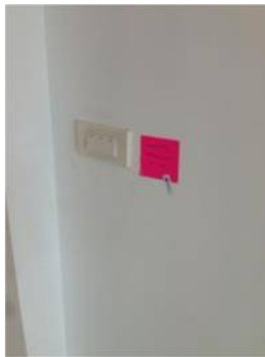
2. ติดตั้งสวิตช์ไฟใหม่ เพราะติดแค่ 2 ดวง ให้เป็น 4 ดวง
