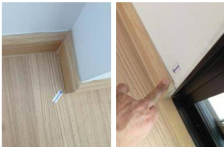
6. เก็บงานซิปิโคนไม่เรียบร้อยมีช่องว่างระหว่างผนัง
