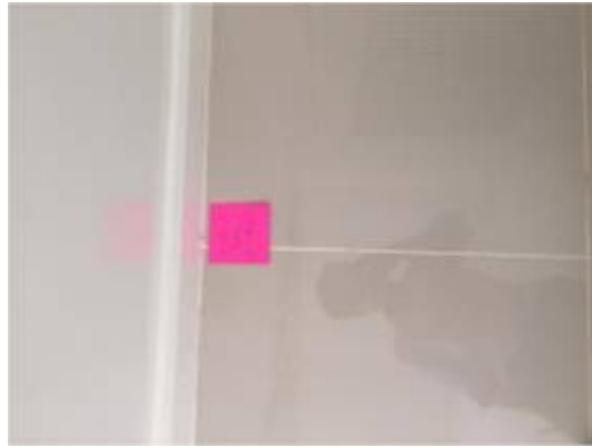
5. ขอบบัวไม่เรียบ ( บวบ + สีพอง )
