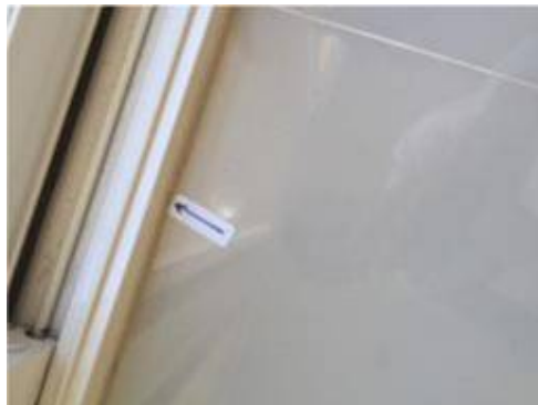
5. เก็บงานซิลิโคนตรงขอบประตูหน้าต่างระเบียง
