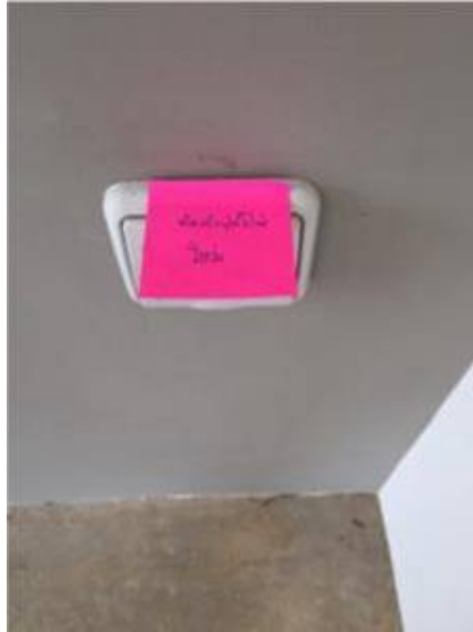
ติดตั้งปลั๊กไฟใหม่
