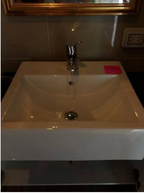
4. ก๊อกน้ำอ่างล้างหน้าไหลไม่แรง. เช็คระบบน้ำ
