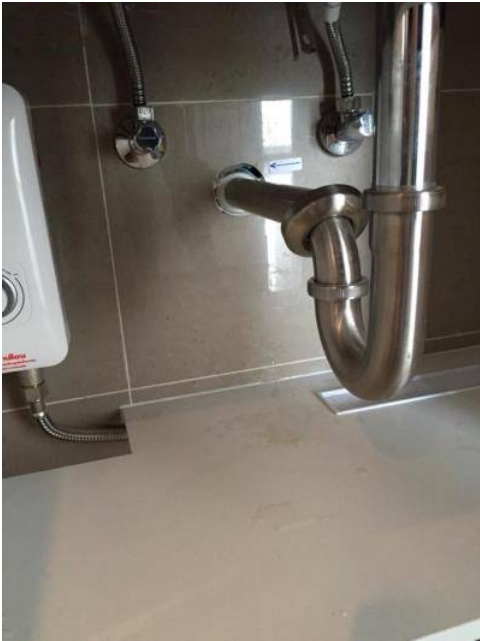
3.เก็บงานท่ออ่างล้างหน้าให้เรียบร้อย + เปลี่ยนกระเบื้องใหม่
