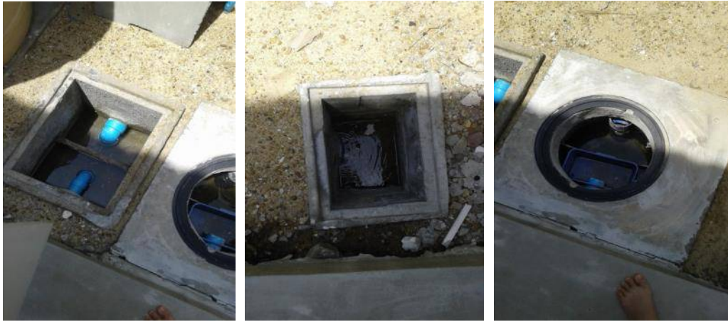
3.ทำความสะอาดท่อระบายน้ำ บ่อพัก และบ่อดักไขมัน
