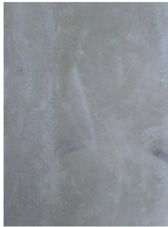
4.ฉาบพื้นหลังบ้านใหม่พื้นไม้เสมอกัน
