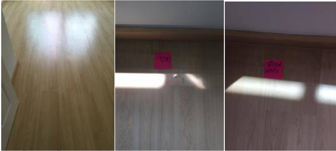
2. เช็ดพื้นยวบ + พื้นลามิเนตห่าง+ ทำความสะอาดพื้น
