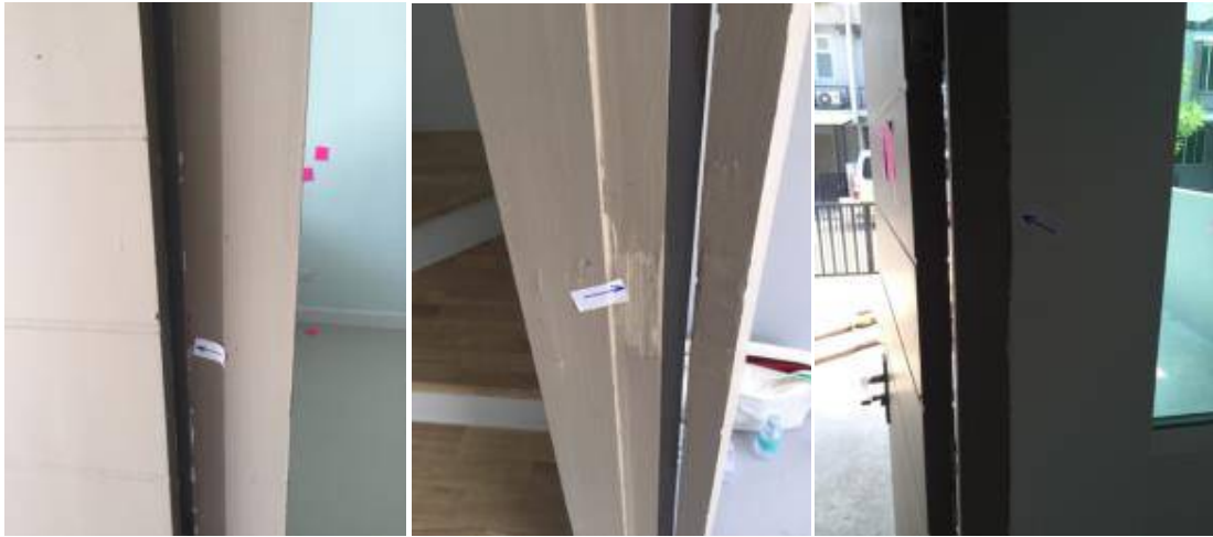
1. แต่งวงกบประตูใหม่+ทาสีใหม่
