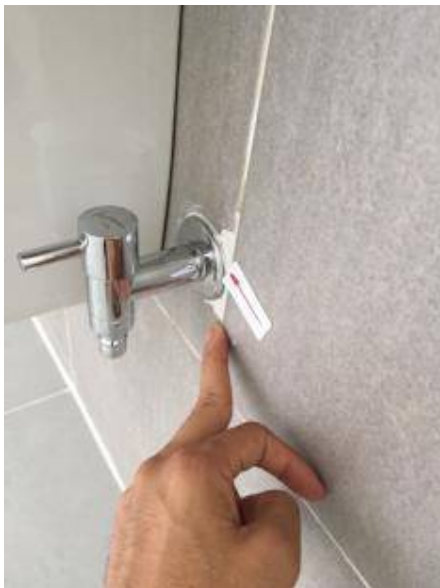
7. เปลี่ยนกระเบื้องผนังตรงก๊อกน้ำแตก 1-2 แผ่น
