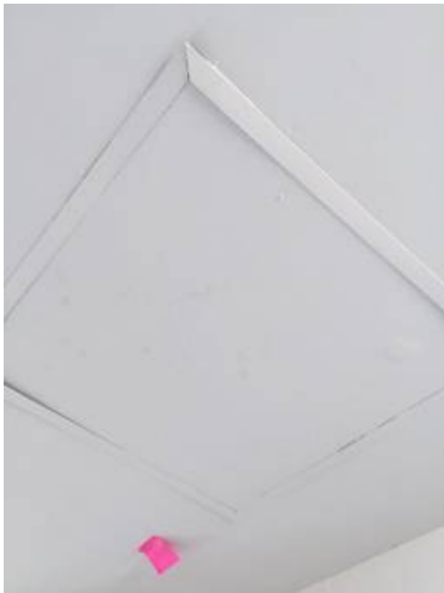
6. เก็บงานสีฝ้า + ช่องเซอร์วิสทำใหม่
