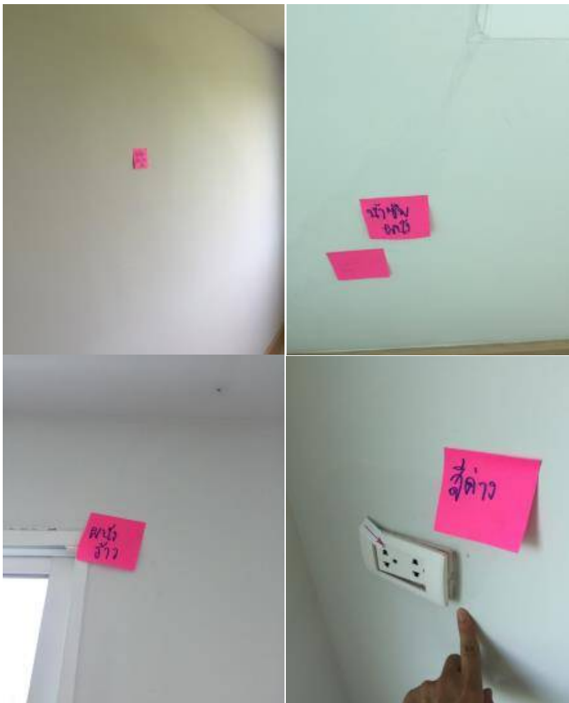
6.ผนังไม่เรียบเก็บงานสกินผนัง + ทาสีผนังใหม่ + ผนังมีรอยน้ำซึม ผนังร้าว ผนังต่าง
