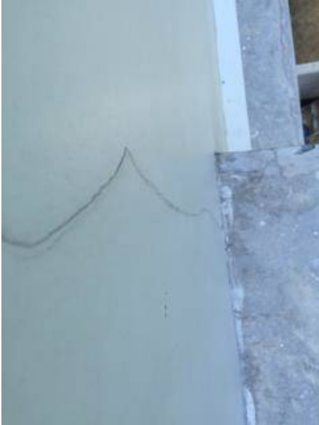
หมายเหตุ ผนังมีน้ำซึม นอกกระเบื้องตรงหน้าต่าง.
