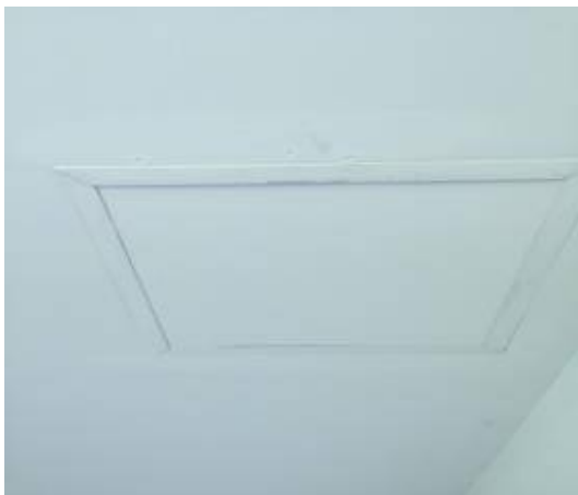
9. ฝ้าไม่เรียบ ฝ้า เป็นคลื่น เก็บงาน สี ฝ้า + ช่องเซอร์วิส
