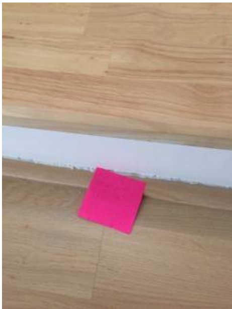
2. เก็บงานรอยต่อระหว่างชั้นบันไดกับชานพัก
