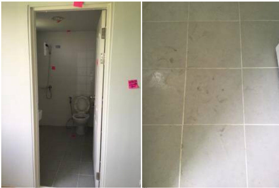
1. ยานแนวพื้นใหม่ + ทำความสะอาด+กระเบื้องล่อน1แผ่น
