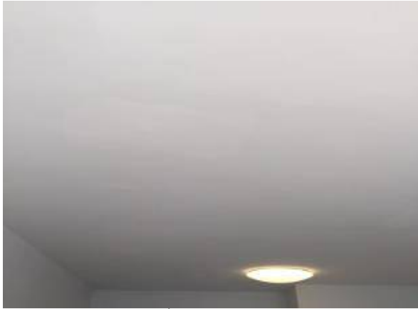
7.ฝ้าไม่เรียบฝ้าเป็นคลื่นเก็บงาน สีฝ้า
