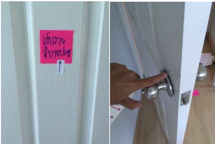
2. เก็บงานสีบานประตู+ ลูกบิดเป็นคราบ ติดลูกบิดไม่เรียบร้อย
