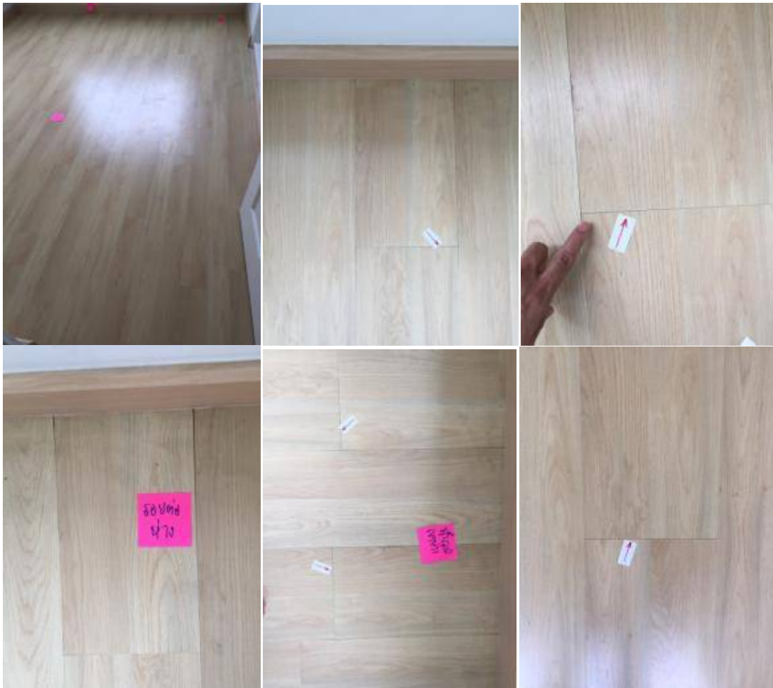
4.ขีดทำความสะอาดพื้น+ พื้นลามิเนตห่าง เช็คทุกแผ่น
