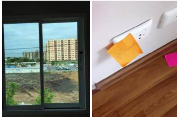
เก็บงานวงกบหน้าต่างบานเลื่อน โดยรอบทั้งหมด+ยิงฉลิต โคนขอบปลั๊ก
