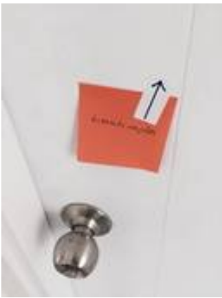
3. ลูกบิดเป็นคราบ (เปลี่ยนลูกบิดใหม่)
