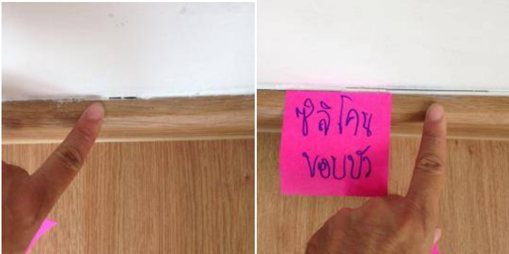
2. ซีลโคนขอบบัวโดยรอบทั้งหมดทั้งด้านบนและด้านล่าง
