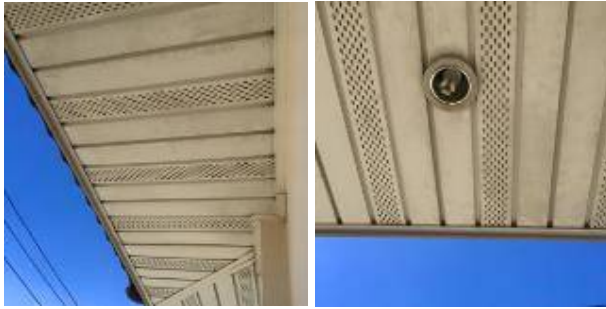
เก็บงานสีใต้หลังคา+เปลี่ยนดาวไลท์
