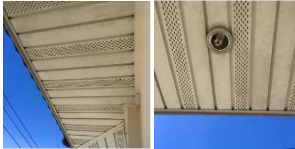
เก็บงานสีใต้หลังคา+เปลี่ยนดาวไลท์
