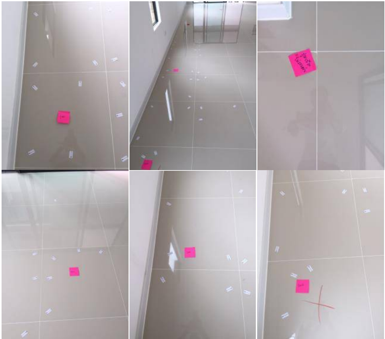
1. กระเบื้องพื้นโพรง+กระเบื้องเป็นรอย+เปลี่ยนกระเบื้องใหม่ทั้งหมดที่โพรง
