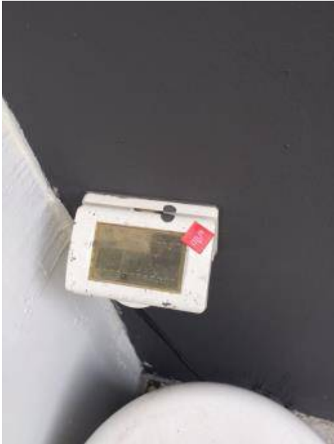
5.ทำความสะอาดสวิตช์ไฟ.
