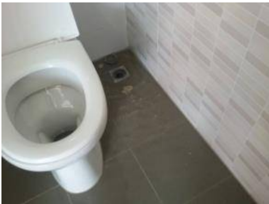
ทำความสะอาดเศษ ปูนภายในท่อระบายน้ำทั้งหมดภายในบ้าน
