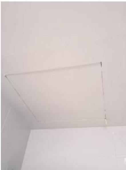
4.เก็บสีเพดานผ้าตรงช่องเซอร์วิส
