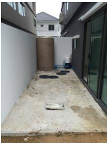
1.ทำความสะอาดพื้น+ขัดพื้นใหม่ เก็บงานปูนใหม่ เพราะพื้นร้อน
