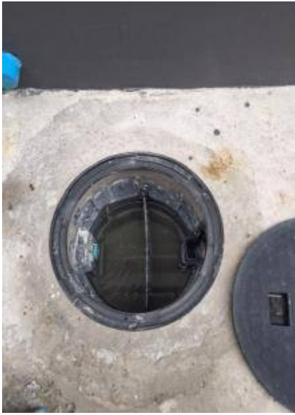
2. ติดตะแกรงดักไขมัน
