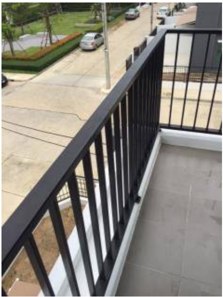
ทำความสะอาดรางระแนง
