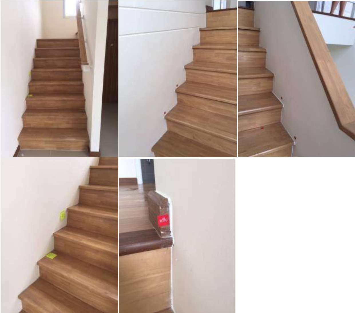
1. เก็บงานสี+ยาแนวขอบบันไดใหม่ให้เรียบร้อย เช็คทุกชั้น
