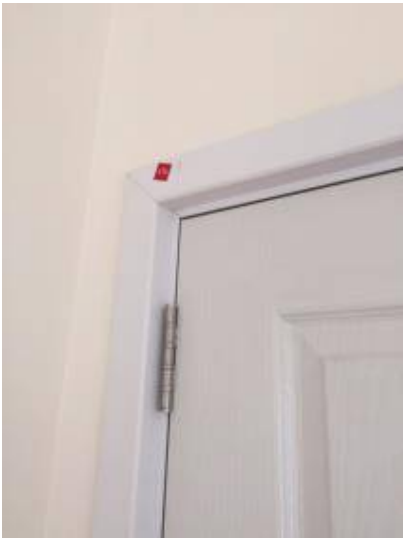
1. เก็บทำความสะอาดประตูวงกบ + กั้นชนติดตั้งไม้สนิท
