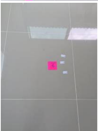
3. ยานวพื้นที่ไม่เต็มทุกแผ่น+เช็คกระเบื้องโพรง+ กระเบื้องเป็นรอย เช็คทุกแผ่น
