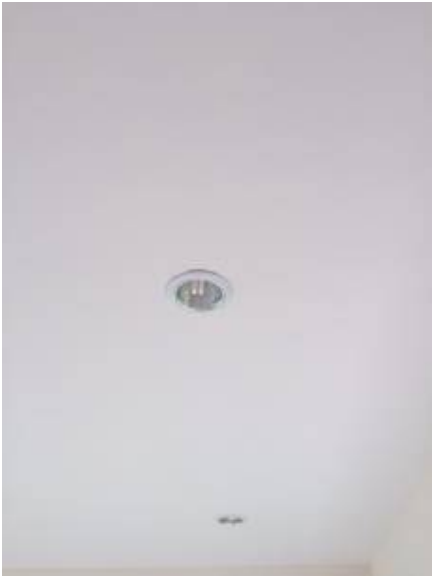
7.ครอบดาวไลท์ไม่สนิท 1 ดวง
