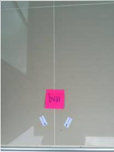
3. ยานวพื้นที่ไม่เต็มทุกแผ่น+เช็คกระเบื้องโพรง+ กระเบื้องเป็นรอย เช็คทุกแผ่น
