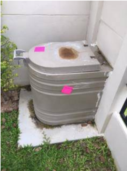
4. เปลี่ยนฝาถังขยะใหม่+ขัดทำความสะอาดพื้น
