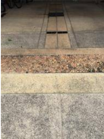
1. รื้อพื้นโรงรถ. ปูกระเบื้องโรงรถใหม่
