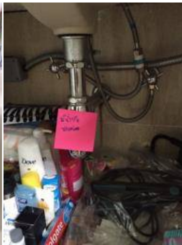
6. ไม่มีสะดืออ่างล้างหน้า+น้ำซึมดินหย่อยใต้อ่างล้างหน้า+เก็บส้วมใต้อ่าง
