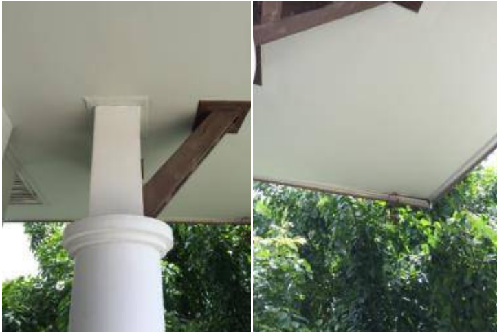
4. ซ่อมแซมเสาค้ำฝ้า+เปลี่ยนบัวเพดานฝ้า
