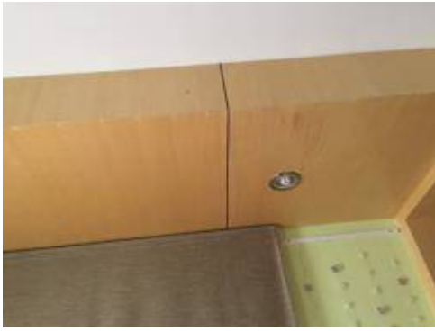
4. ซ่อมแซมฝ้ากล่องหัวเตียง+เปลี่ยนหลอดไฟ
