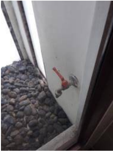
5 ติดตั้งอุปกรณ์ก๊อก
