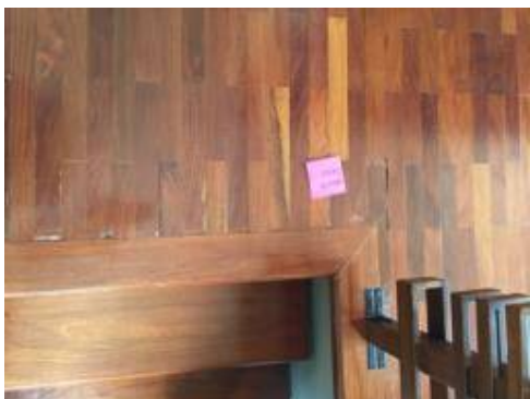
1. ซ่อมแซมไม้ปาเก้
