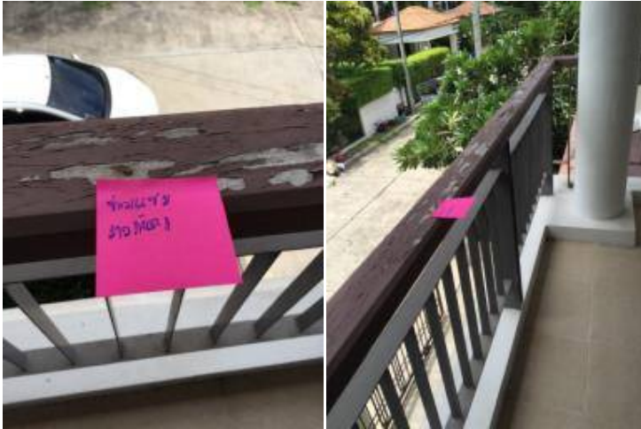
1. ซ่อมแซมราวกันตก+เก็บสีเหล็ก
