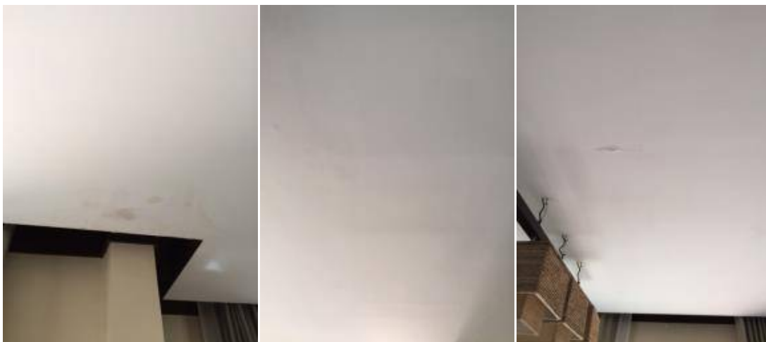
5. ฝ้า เซ็คน้ำรั่วซึม+ฝ้าเพดานเป็นคลื่นเก็บสีฝ้าใหม่
