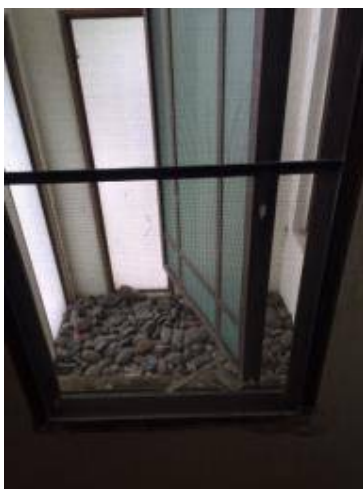
4. ซ่อมแซมหน้าต่างบานเปิดในห้องอาบน้ำ
