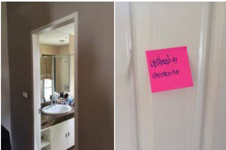
1. เปลี่ยนประตูปะตู+วงกบประตูปะตู
