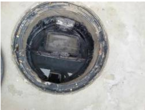
4. ทำความสะอาดถังดักไขมัน
