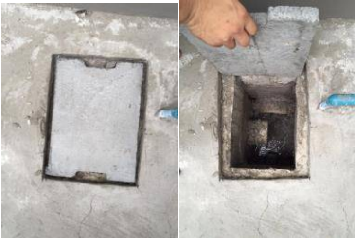
3.ฝาท่อแตกรอบท่อ ทำความสะอาดรอบท่อ
