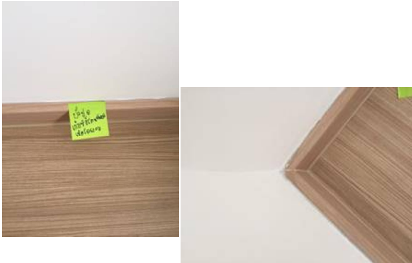
4. เก็บซึลโคนด้านบนโดยรอบ+เก็บงานสีเลอะบัวทั้งหมด
