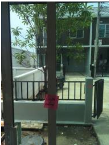
1. ประตูบานเลื่อนฝ้าติดตั้งใหม่+เก็บสี
