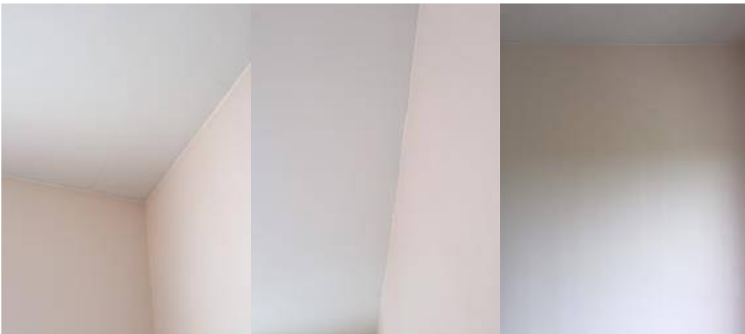
5. ใช้น้ำรั้วซึม+เก็บสีฝ้าทั้งหมด
