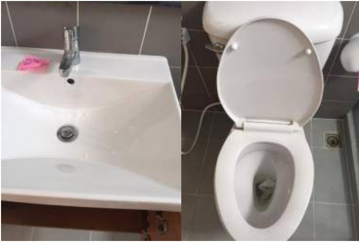
4. น้ำไหลไม่แรง เช็คอุปกรณ์+เช็คระบบชักโครกเพราะกด3-4ครั้งไม่ลง *ไม่ได้ติดปั้มน้ำ
