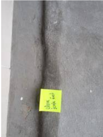
4. พื้นโรงรถ เก็บรอยแตก+สีหยด+ปูนร่อน+สกินผิว+เก็บงานร่องปูนจอยส์
