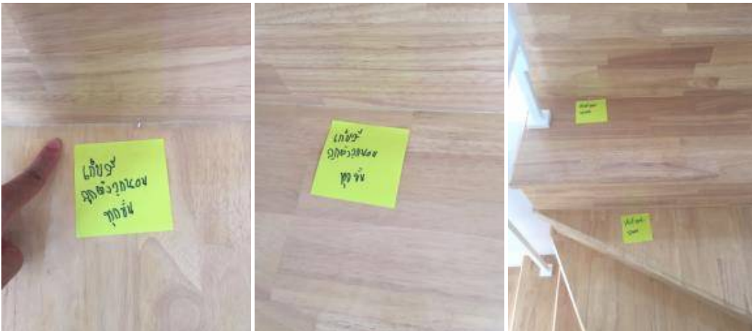
2. เก็บสีลูกล้างลูกนอนบันได เช็ดทุกชั้น
