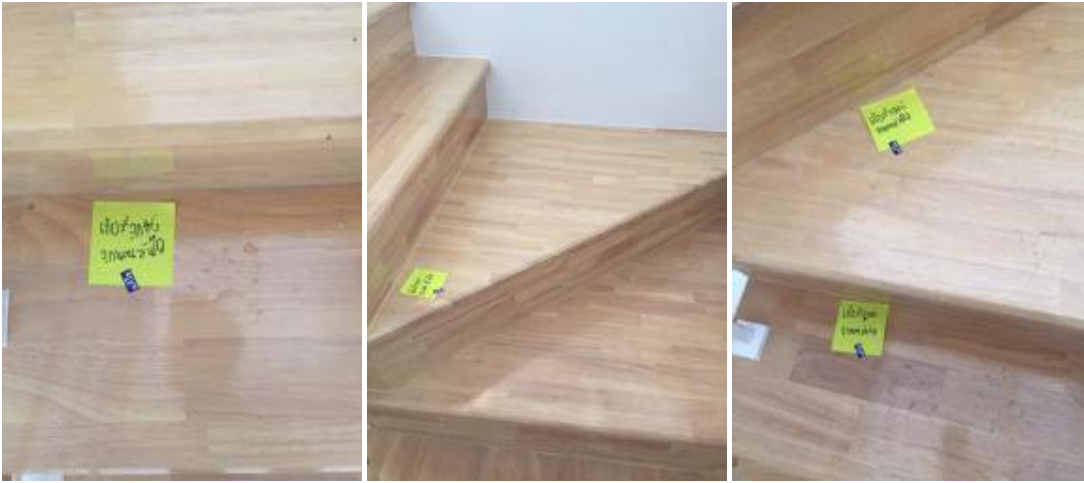
2. เก็บสีลูกตั้งลูกนอนบันได เช็คทุกชั้น
